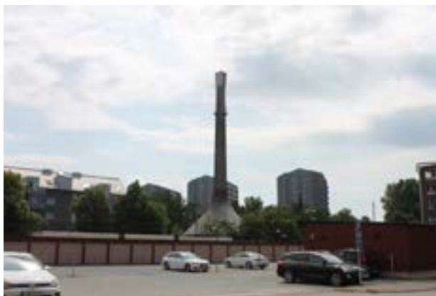
Bild: Före detta panncentralen, Tratten
